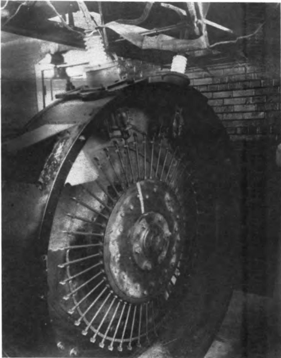
OLD NAA - CLOSE UP OF THE SYNCHRONOUS ROTARY GAP OF THE 100 KW SPARK TRANSMITTER FURNISHED THE NAVY BY FESSENDEN
